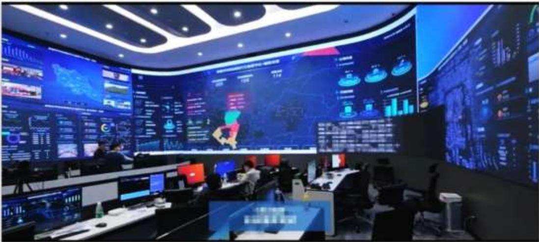
蔚来墙护眼大屏幕基于大屏幕控制系统和其它系统的结合体，在大数据流以及多路公安、交警、消防等部门的业务需求的情况下，通过对各个系统包括 CCTV 监控、信号灯控制、数据采集等系统集成在一起，形成了能够作战指挥调度的“电子沙盘”。为指挥和调度提供详细的内容、准确高效清晰的显示平台，能够以实战的需要来进行显示，能够对各种信号源、网络资源等信息进行实时的监控、分析和智能化管理，并且能够及时作出预案、方案并确保指挥人员的决策、命令能稳妥迅速的传达和反馈下去，从而保证整个指挥系统具有联动性、高效性、完整性。
