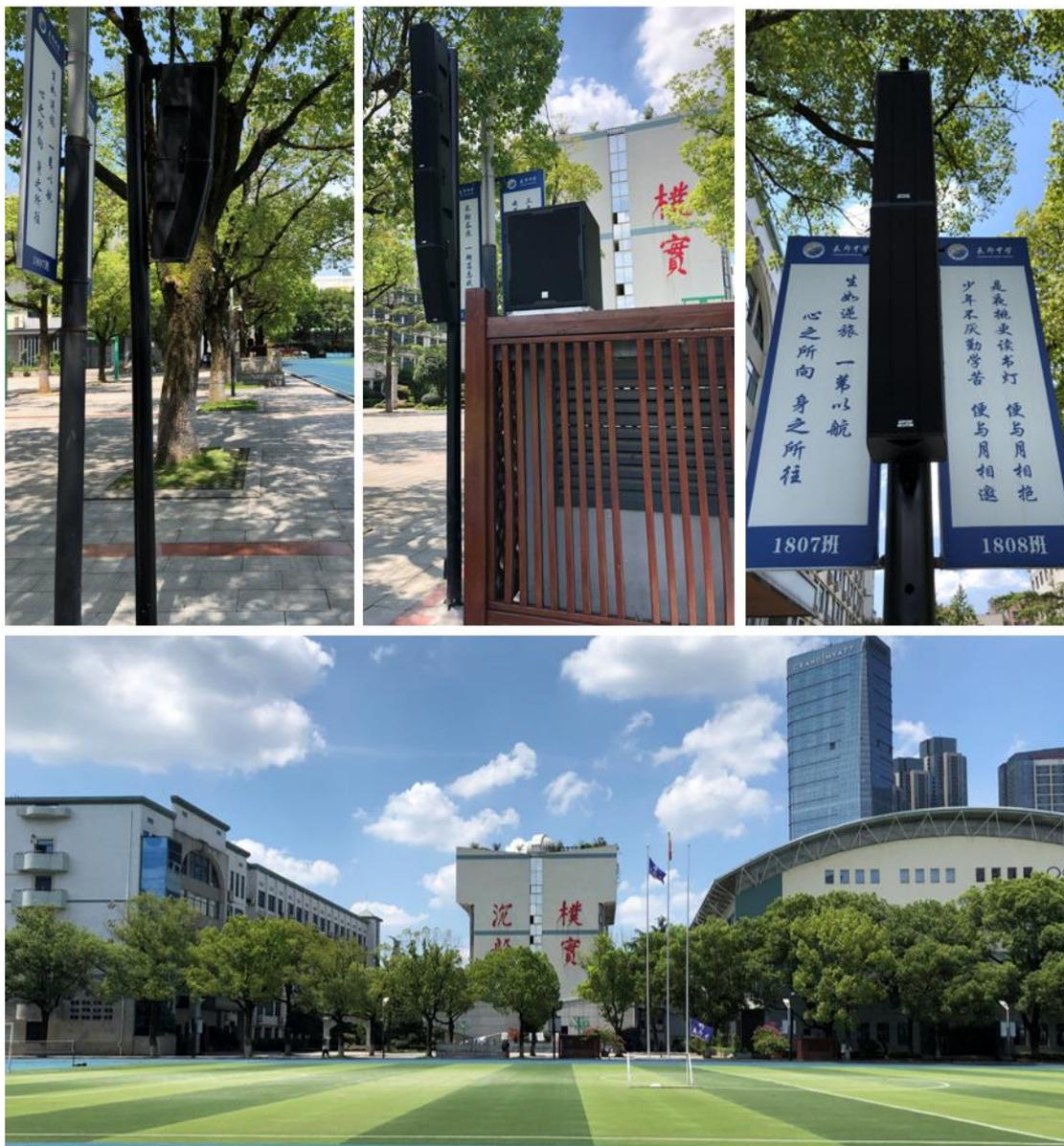
**项目介绍：**长沙长郡中学是湖南省示范性普通高级中学，作为一所百年学府，长郡更是被称为长沙“四大名校”之一。由于操场外围靠近闹市商业区，音量过大容易造成扰民，以及操场现场主席台无顶棚的安装条件，世邦从长郡中学实际情况出发考虑建筑特点和扩声需求，选择部署轻量化的线性音箱，搭配补声音箱等，实现声场均匀，保证操场区域各角落位置声音清晰可辨。考虑到操场区域广阔，话筒使用距离远的特点，所以部署了定向天线系统提高话筒的稳定性，让户外声音传播达到最佳效果。
