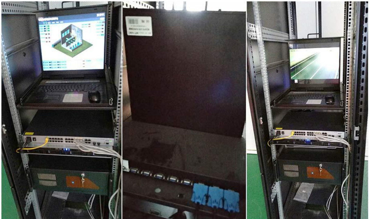
(部分现场图片)
