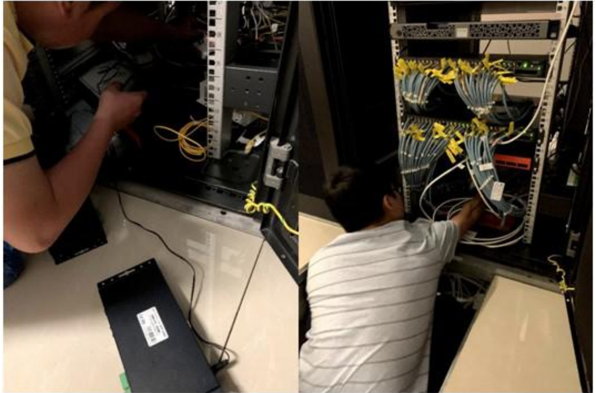
安装中控和发射端
